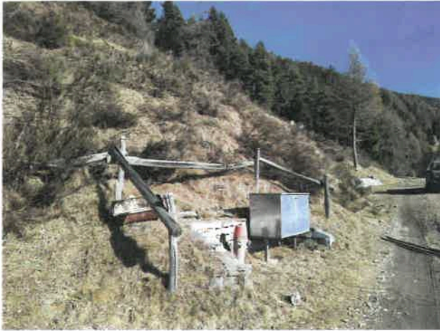
Scarpata ripida sopra Fararena con ginestre
