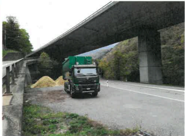
Deposito intermedio truciolato Ecomassa SA
